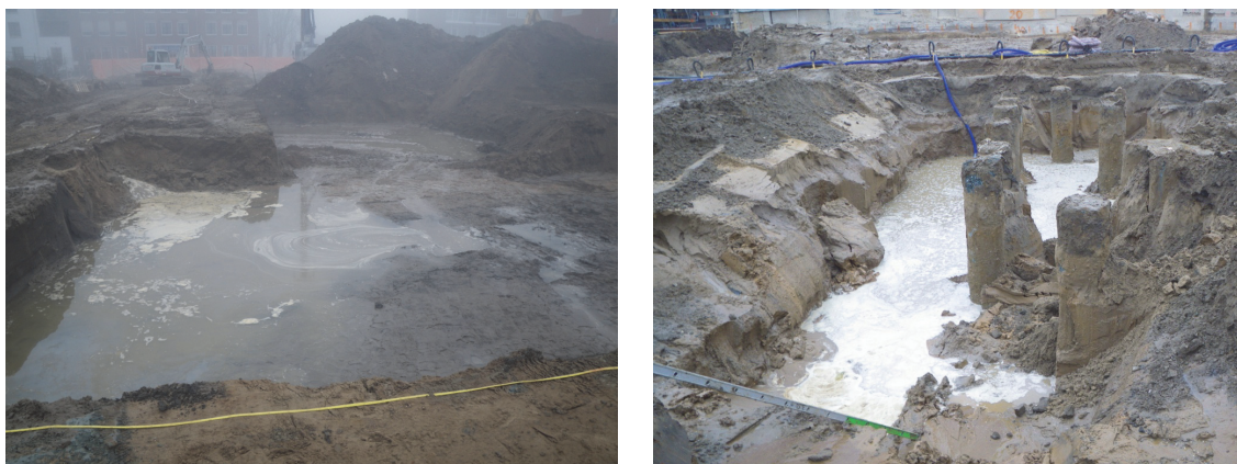
Fig. 4.2: Links: november 2010, wateroverlast. Rechts: februari 2011, door niet optimale bronnering loopt de bouwput vol water.
