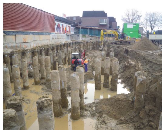
Fig. 4.4: Minigraver tussen de funderingspalen.
