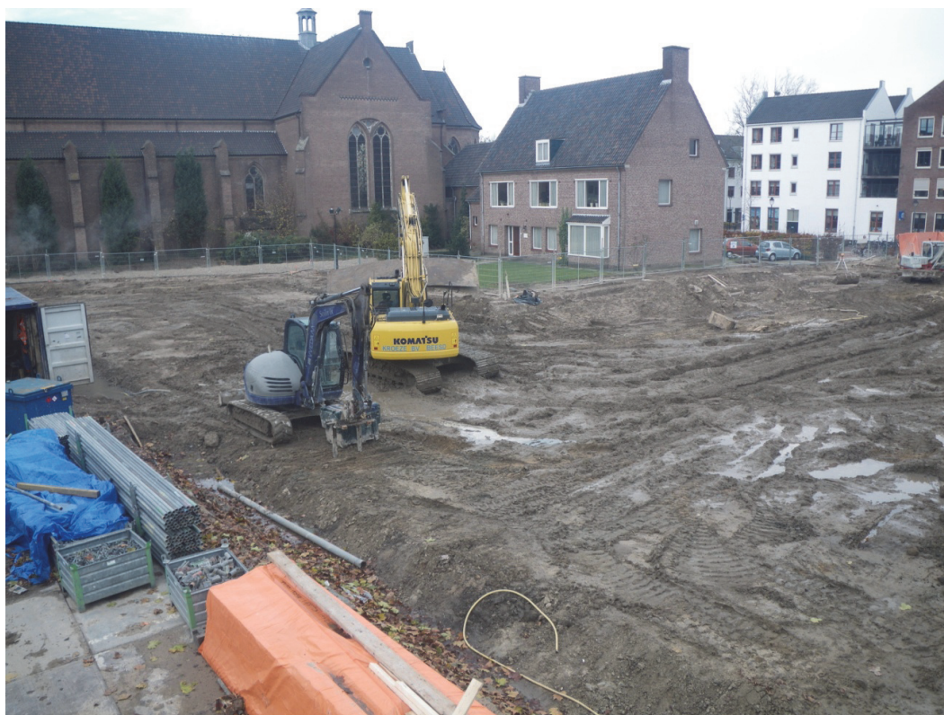
Fig. 1.2: Het plangebied bij aanvang van de werkzaamheden.
