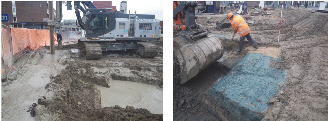
Fig. 4.1: Links: de frees injecteert soilmix in de grond. Rechts een blauwgrijs brok uitgeharde soilmix.
